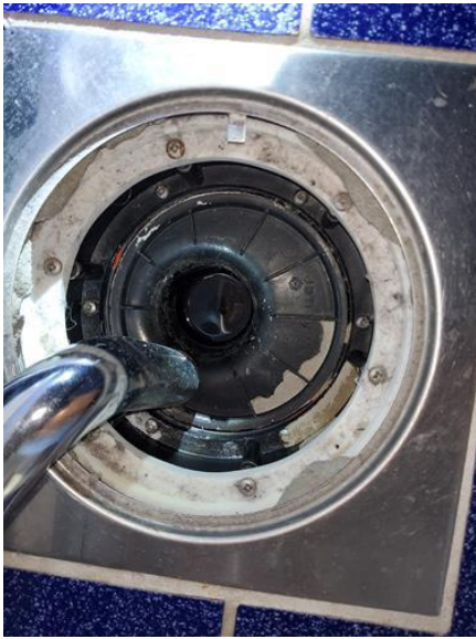
Membran, tettesjikt og overgang til sluk. - [Sluk i bad 2. etg.]
