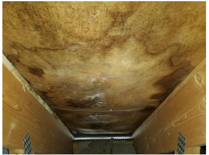
Overflater vegger/undertak - [Undertak over ventilasjonsaggregat på kaldtloft. ]
