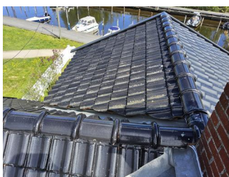
Tekking (med tilhørende beslag) - Taktekking.
