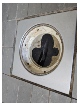
Tettesjiktets tilslutning til sluk - Sluk i bad 2. etg.
