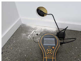
Utført kontroll i tiliggende konstruksjon - Fuktmåling bad 1. etg.
