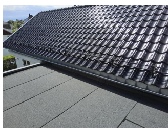
Tekking (med tilhørende beslag) - Taktekking.
