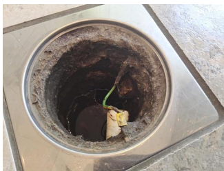
Vanntett sjikt / membran i golv og vegger - Sluk utenfor dusjsone, bad underetasje.
