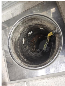
Vanntett sjikt / membran i gulv og vegger - Sluk utenfor dusjsone, vaskerom underetasje.
