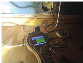
Utført kontroll i tillegg konstruksjon - Fuktmåling vaskerom underetasje.
