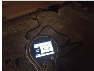
Kontroll i lukkede konstruksjoner - Fuktmåling rom under terreng.
