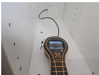
Utført kontroll i tilliggende konstruksjon - Fuktmåling bad 1. etg.
