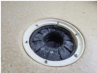
Tettesjiktets tilslutning til sluk - Sluk i vaskerom
