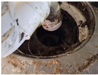
Tettesjiktets tilslutning til sluk - Sluk i bad 2 etg.
