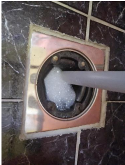
Vannnett sjikt / membran i gulv og vegger - Sluk i vaskerom.
