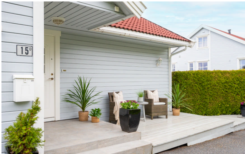
Flislagt plattning mot øst
