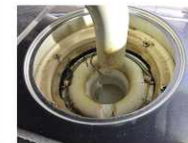
Tettesjiktets tilslutning til sluk - Sluk i bad.
