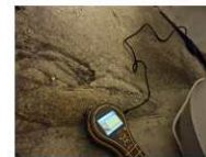
Kontroll i lukkede konstruksjoner - Fuktmåling rom under terreng
