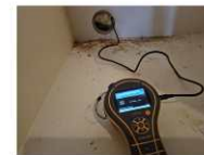
Utført kontroll i tiliggende konstruksjon - Fuktmåling bad.
