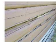
Ytterkledning (fasademateriale, vannbord, utvendig listverk, o.l.) - Fasade mot sydvest.
