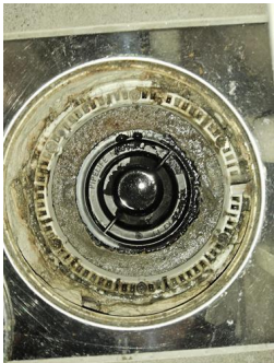
Tettesjiktets tilslutning til sluk - Sluk vaskerom
