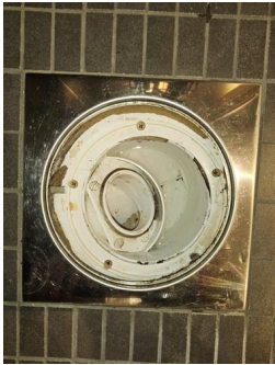
Tettesjiktets tilslutning til sluk - Sluk bad 1
