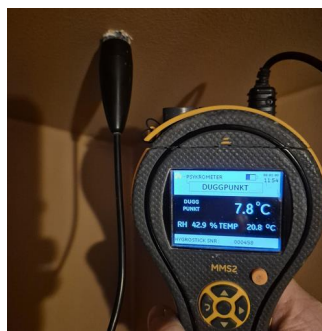
Utført kontroll i tilliggende konstruksjon - Fuktmåling bad 2
