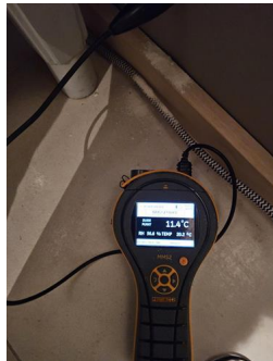
Utført kontroll i tilliggende konstruksjon - Fuktmåling vaskerom
