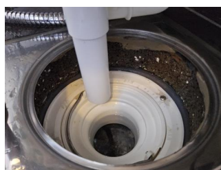
Vanntett sjikt / membran i gulv og vegger - Sluk under badekar.
