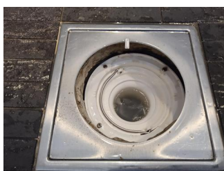
Vanntett sjikt / membran i gulv og vegger - Sluk i dusjsone.
